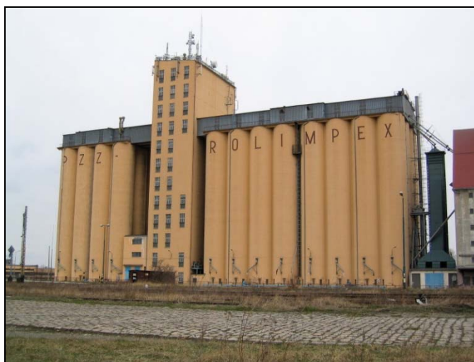
Rys. 1. Elewator silosowy w Prudniku
