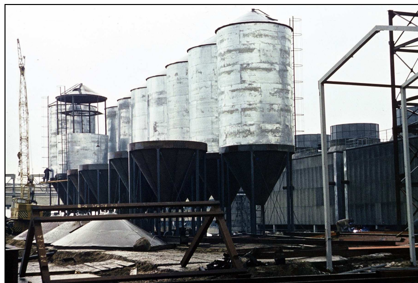
Rys. 4. Bateria zbiorników o pojemności V = 150 \text{ m}^3 Fig. 4. Silo battery of the volume V = 150 \text{ m}^3
