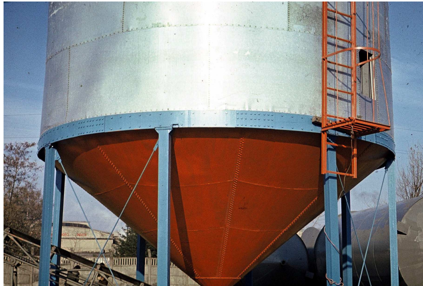
Rys. 3. Lej spustowy wraz z pierścieniem dolnym Fig. 3. Release funnel with a bottom ring
