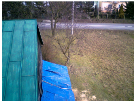
Rys. 2. Zdjęcie fragmentu dachu budynku stodoły Fig. 2. Photograph of barn building roof fragment
