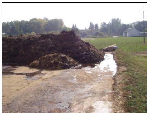
Rys. 3. Płyta niespełniająca wymagań szczelności, gnojówka przedostaje się do gruntu [fot. W. Wardal] Fig. 3. Slab failing to meet leaktightness requirements, liquid manure penetrates into the ground
