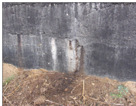
Rys. 4. Nieszczelności murka oporowego [fot. B. Łochowski] Fig. 4. Leaks in retaining wall
