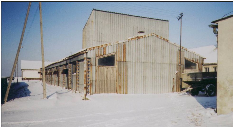
Rys. 1. Częściowo przeszklona paszarnia osłaniająca od południowej strony budynek z samoogrzewalnymi i bezokiennymi tuczarniami
